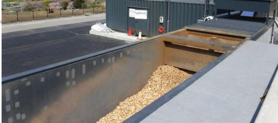
木質チップを燃料とする「森林（もり）の発電所」。発電規模は45kW。
